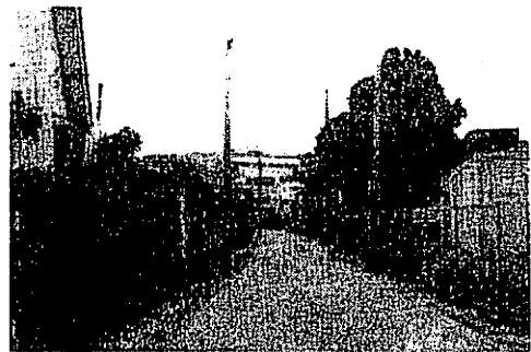
フェンスの側だけ部分的に拡巾された道路
