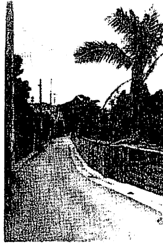
きれいに舗装され、両側にU字溝が設置されている。
