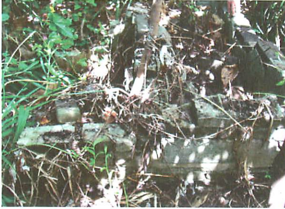
（写真3：山頂付近の基礎部分）
