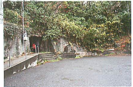
写真11：豊砲台跡の入口付近
