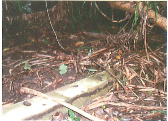
（写真4：一段下のコンクリート基礎）
