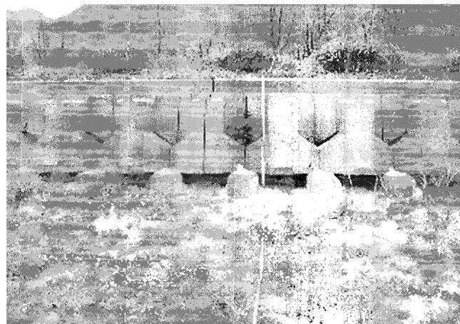
写真15. 低直立空洞型護岸工, 砂浜からの高さは約1.5m (アンジェーラの浜, 渡名喜島).
