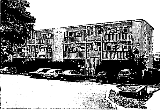
写真-1 実在建築物の外観（右端の1スパン3層部分が実在実験の対象）
