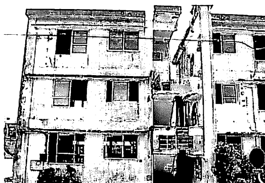
写真-10 建物を切断した後の状況（北面）
