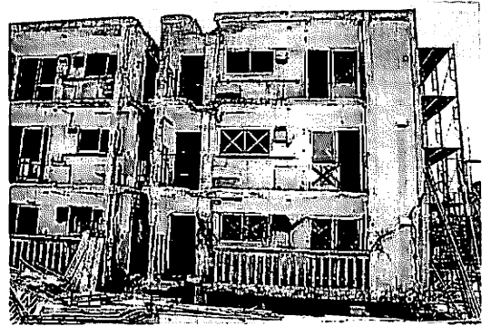
写真-21 1階S通り面の破壊状況の全景
