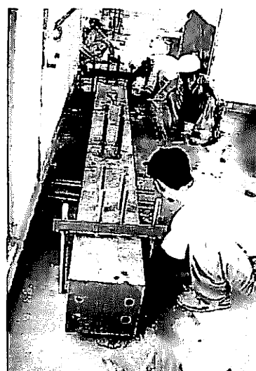
写真-11 加力梁設置の作業風景
