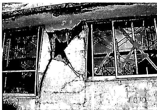
写真-17 1階N通りブロック壁のせん断破壊状況
