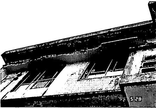
写真-2 塩害により損傷したひさし部分
