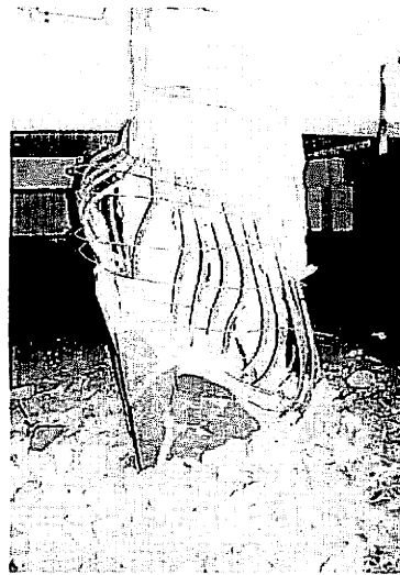
写真-4 写真-3の1階（ピロティ）柱のせん断破壊
