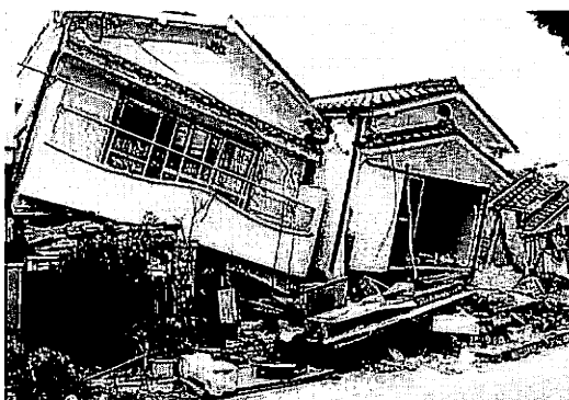
写真-17 2階建て木造住宅の崩壊
