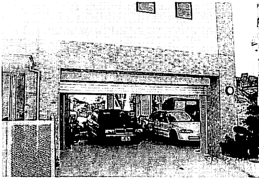
写真-31 被害を受けなかったピロティ
