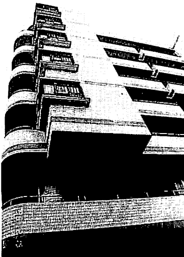
写真-33 片持ち梁を利用したSRC, RC 造8階建てマンション(沖縄)
