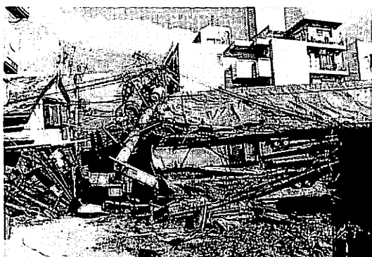
写真-14 古い2階建て木造住宅の崩壊
