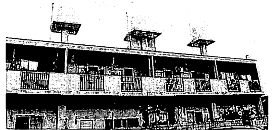
写真-36 屋上に一本柱で支えられた水槽(沖縄)
