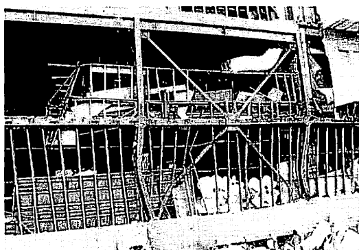
写真-11 柱やブレースの座屈により傾いたS造5階建て倉庫
