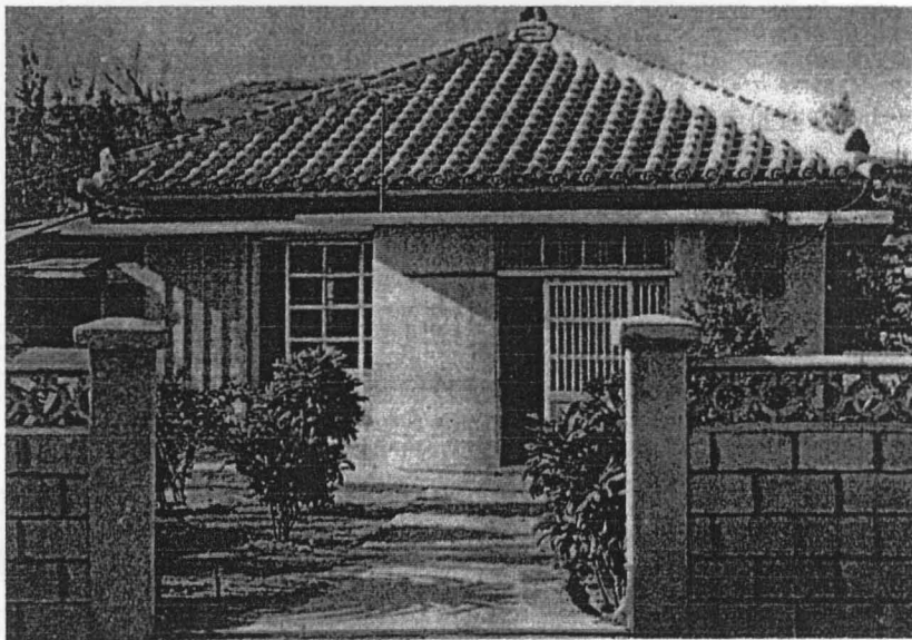
図 2-5 初期コンクリート住宅（コンクリートブロック 帳壁に木造屋根） 1960年代（参考文献 51. より引用）
