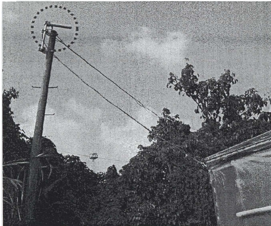
図 2.15: 農場の指向性アンテナ
