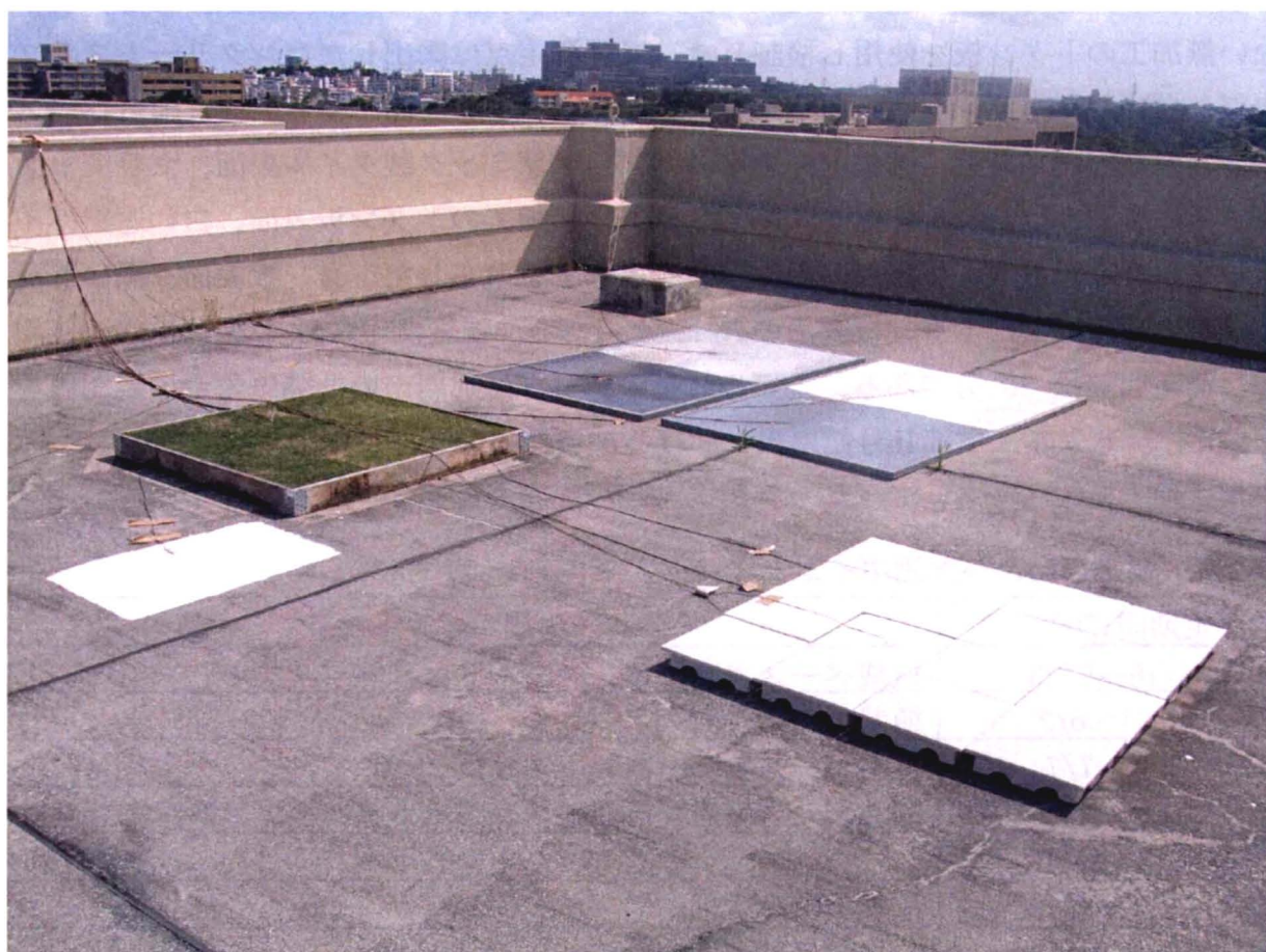
図2.2 琉球大学工学部Ⅱ号館屋上における実際の測定現場
