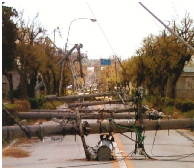
街路樹の被害 (宮古島地方気象台撮影)
