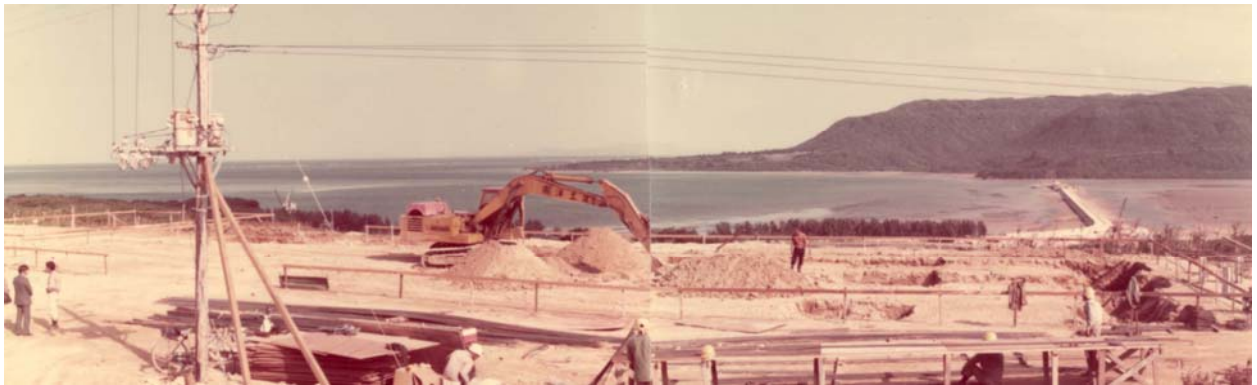
基礎工事が始まる。
