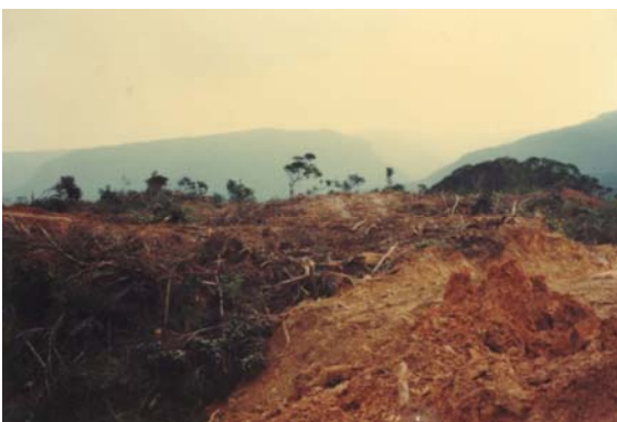
伐採・倒木の処理作業
