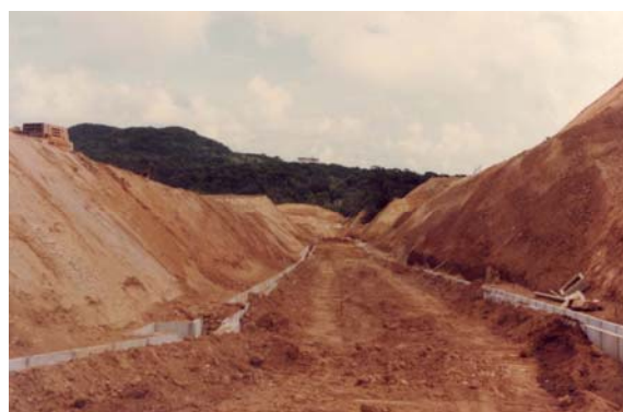
圃場内の道路工事 — 昭和 58 年(1983)9 月 —
