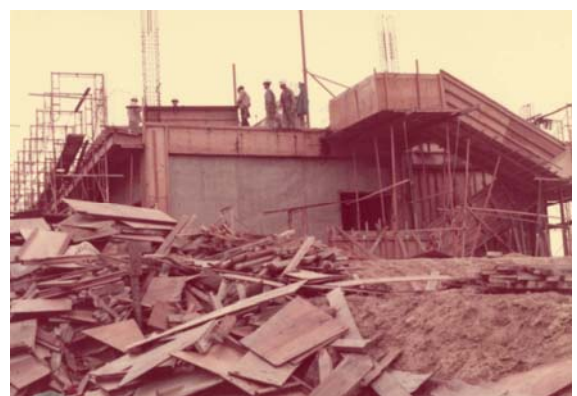
2階の建築工事
