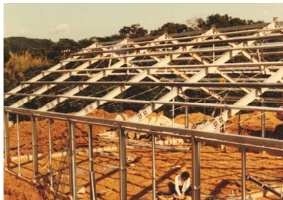
ガラス室の鉄骨組立て — 昭和55年(1980)2月 —
