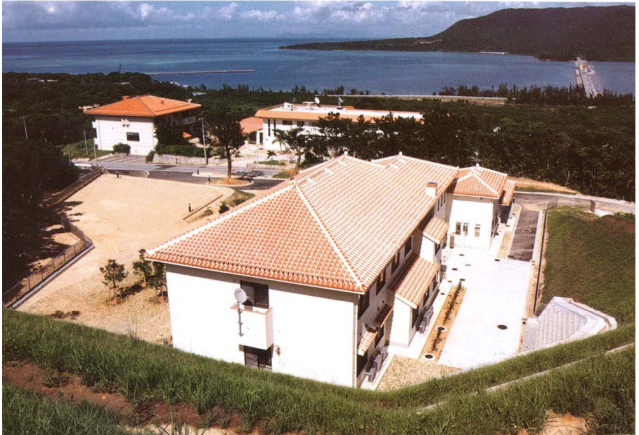
教育研究棟・宿泊棟の全景 — 平成20年2月現在 —
