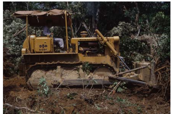
レーキドーザーによる造成
