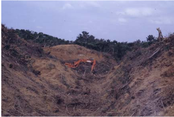
ユンボによる造成が進む。
