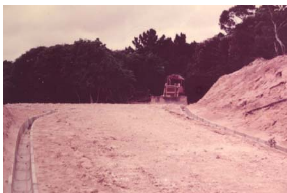
竣工した 2 期工事専用道路 — 昭和 51 年(1976)3 月 —
