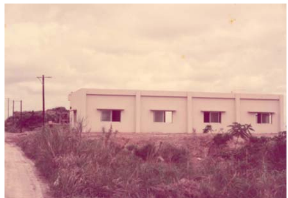
竣工した車庫、裏側より — 昭和 50 年(1975)3 月 —
