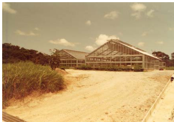
2棟目の竣工したガラス室 — 昭和56年(1981)3月 —
