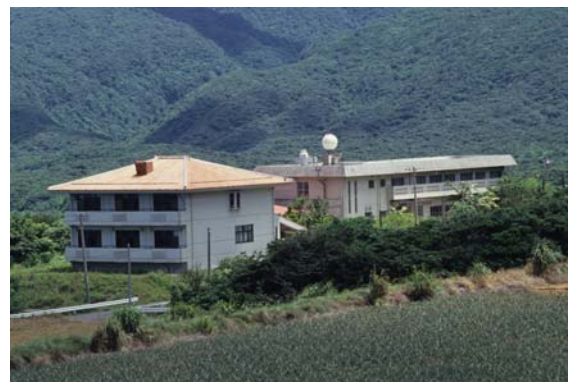
竣工した 2号館 (左)、右は 1号館
