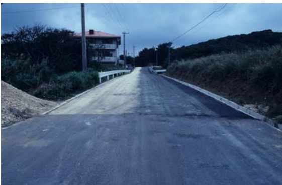
208 林班用地入口付近の舗装工事 — 平成 3 年(1991)3 月 —
