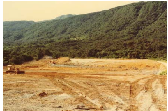
日に日に造成が進む。
