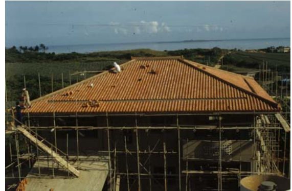
竣工間近の 2号館、赤瓦の工事が急ピッチで進む。
