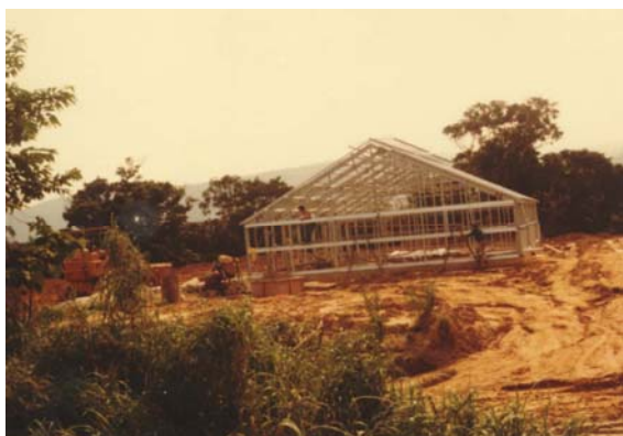
竣工間近のガラス室 — 昭和55年(1980)3月 —
