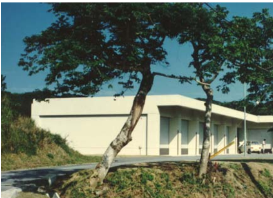
竣工した農用機械格納庫 — 昭和63年(1988)3月 —
