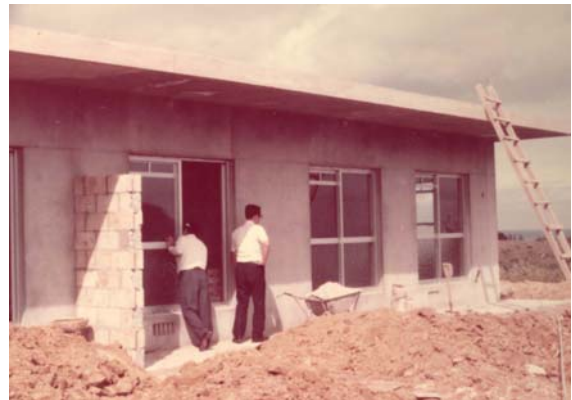
竣工間近の宿舎 — 昭和50年(1975)10月 —
