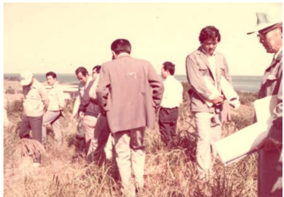
1号館現場説明
