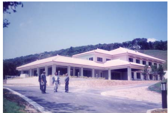
総定員50人の宿泊棟を竣工
