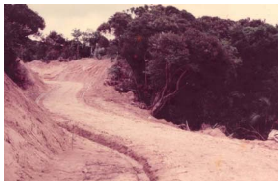
竣工した 208 林班内の 1 期工事専用道路 — 昭和 50 年(1975)3 月 —
