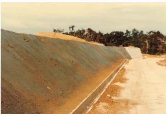
完成間近の法面および道路
