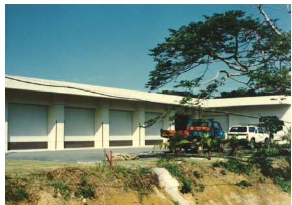
竣工した農用機械格納庫に連結した作業管理棟
