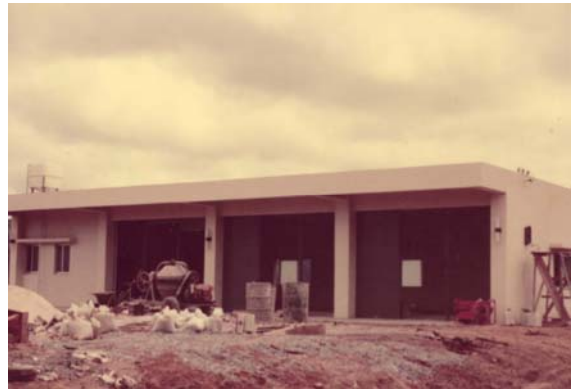
竣工間近の車庫、表側より — 昭和 50 年(1975)2 月 —
