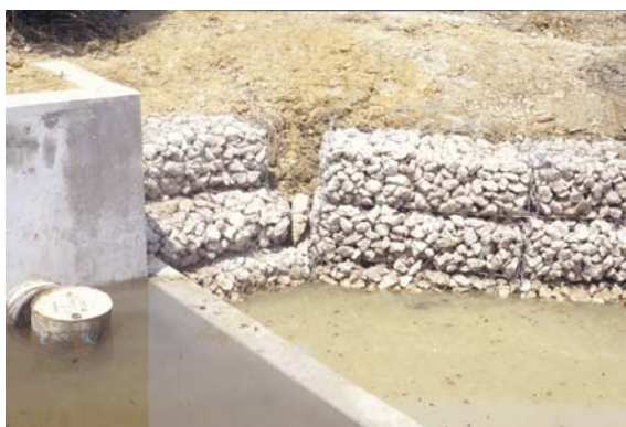
完成したダム — 昭和58年(1983)11月 —
