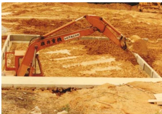
ガラス室の基礎工事 — 昭和55年(1980)1月 —
