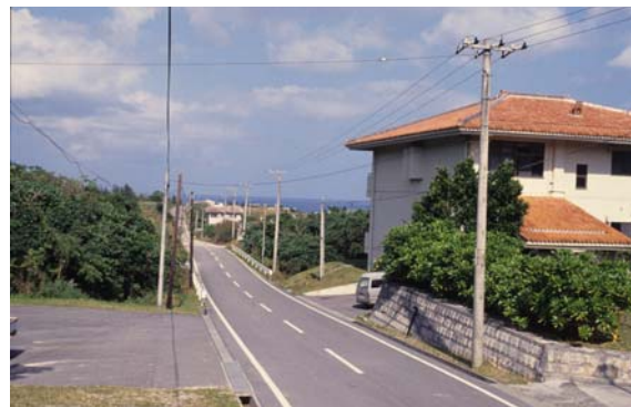
中央の分離白線も施して竣工した道路舗装 — 平成 3 年(1991)3 月 —
