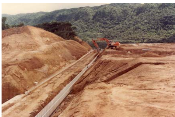
圃場内の道路工事 — 昭和 58 年(1983)10 月 —
