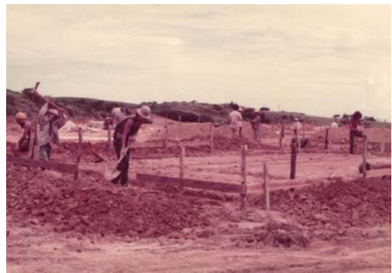
職員宿舎の基礎工事 — 昭和50年(1975)5月 —
