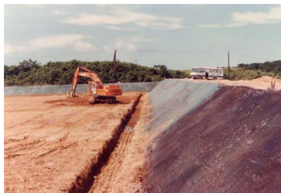
圃場内の道路工事 — 昭和 58 年(1983)11 月 —
