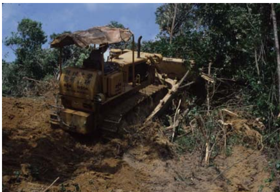
ブルドーザーによる造成
