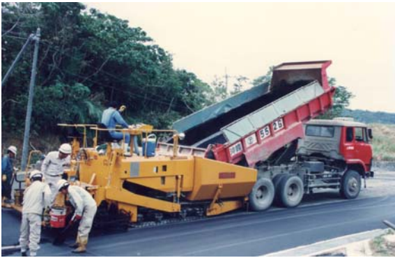
Y字型付近の舗装工事 — 平成 3 年(1991)3 月 —
