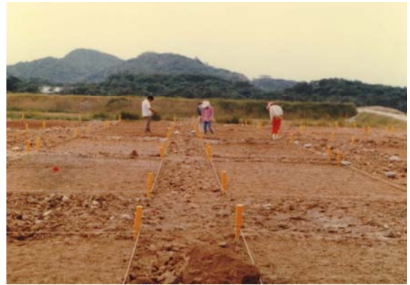
礫の除去作業 6号圃場
