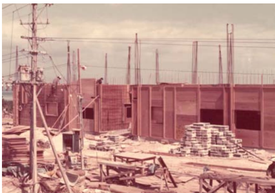
建築中の1階工事
