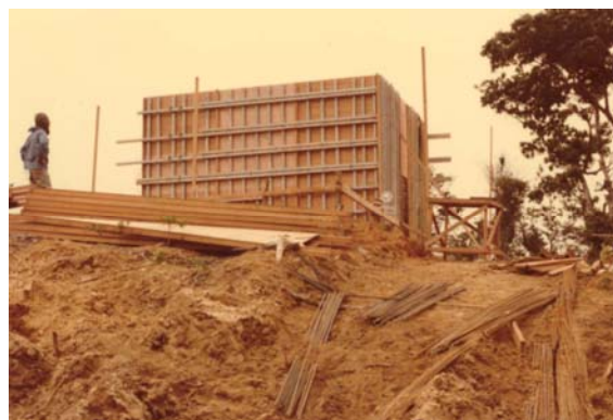
貯水タンクの建設 — 昭和58年(1983)9月 —
