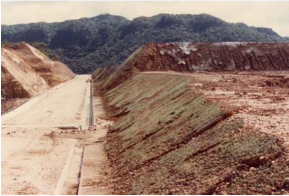
圃場内の道路工事 — 昭和 58 年(1983)11 月 —
