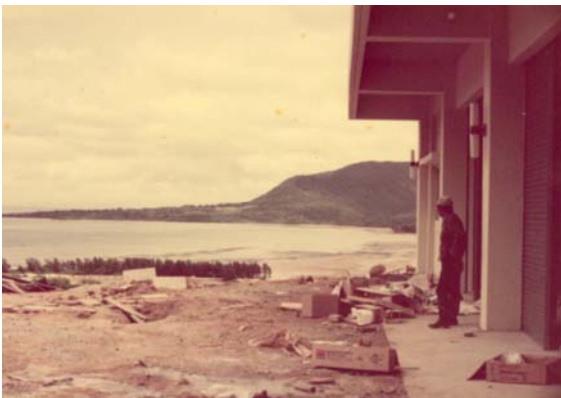
竣工間近の車庫 — 昭和 50 年(1975)2 月 —
