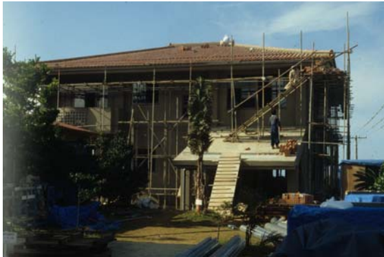
建築中の 2号館
