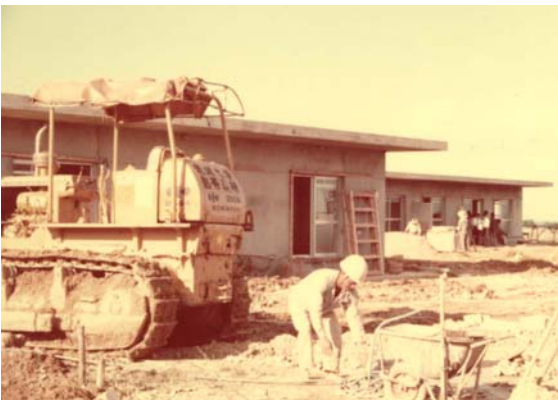
竣工間近の宿舎 — 昭和50年(1975)10月 —
