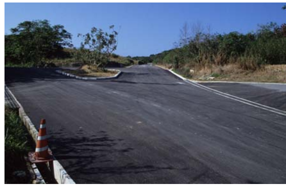
舗装直後のY字型付近 — 平成 3 年(1991)3 月 —
