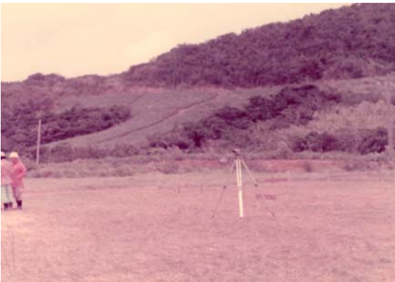
職員宿舎用地の測量 — 昭和50年(1975)5月 —
