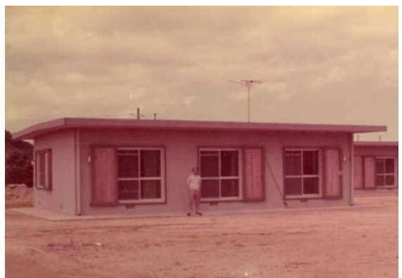
竣工した施設長専用宿舎 — 昭和50年(1975)11月 —
