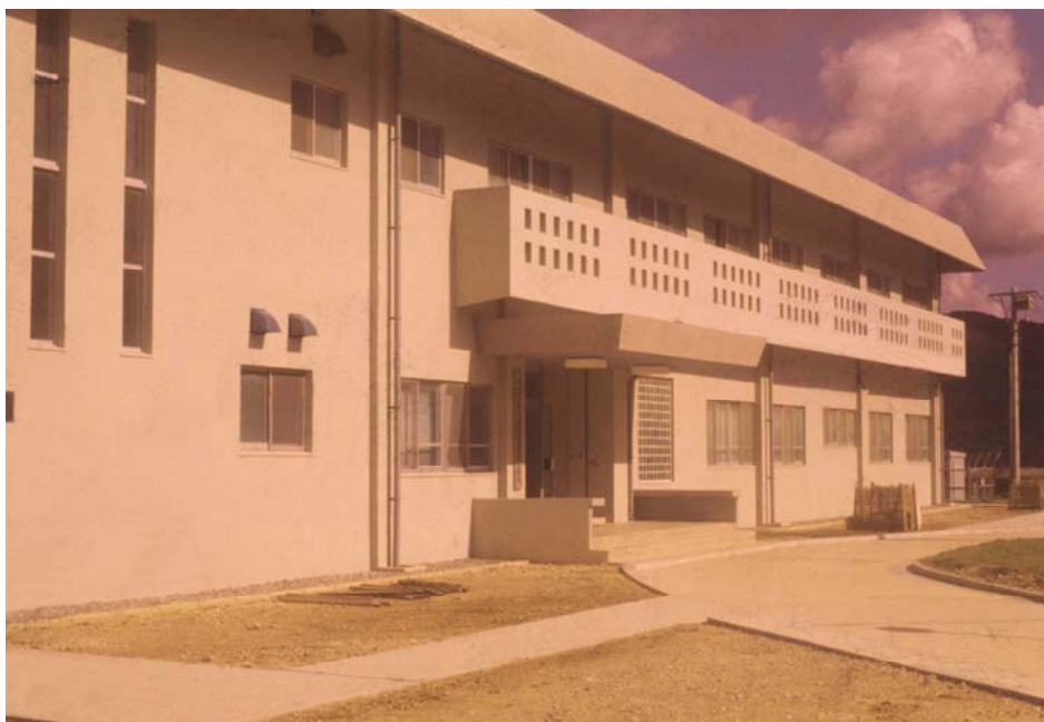
竣工した1号館 — 昭和51年(1976)3月 —
