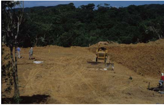
土壌流出試験区の造成
