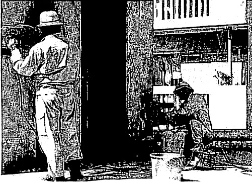
写真-19 渡橋名団地高架水槽添え柱からのコンクリートコアの抜きとり状況
