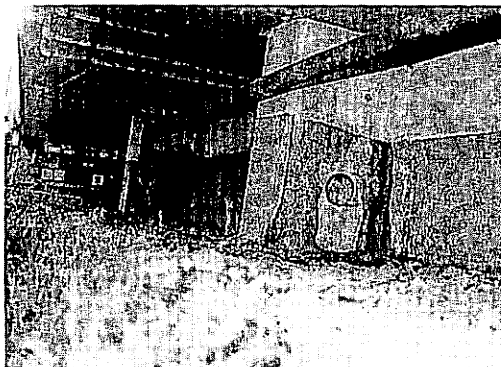
写真-21 上田団地1号棟柱脚部のコンクリートコアの抜きとり
