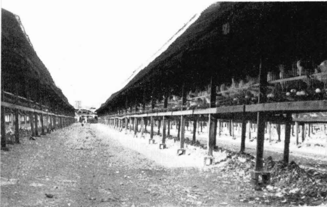
ハワイ最大の伊芸養鶏場の一部 台風の心配はないから施設は簡単 その代り通風 採光 一般衛生は徹底する
