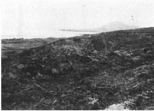
新里部落における地すべり復旧現場
