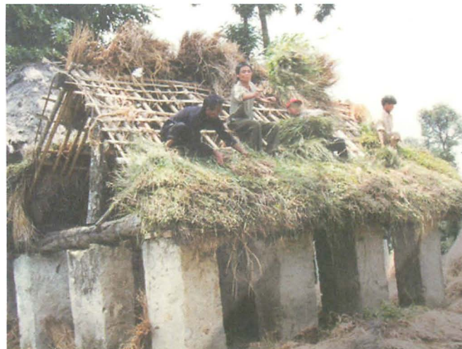
写真33 アチョ小屋の屋根葺き
