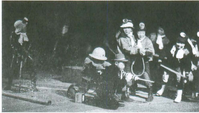
児童によるトンネル工事の劇化
