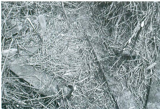
写真15：建物②南西側布基礎（東から）
