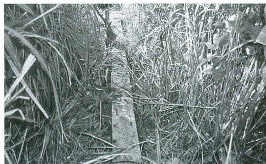
写真8：建物②北側布基礎（東から）
