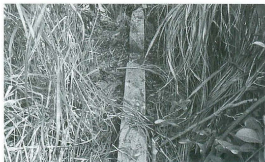
写真7：建物②東側布基礎（北から）
