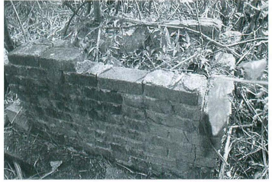
写真10：建物②北西隅の枠組（北西から）
