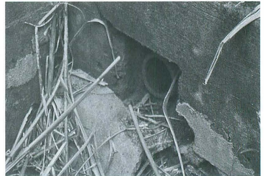
写真14：半地下式の枡内の配水管（南西から）
