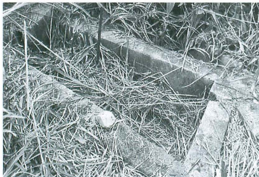
写真13：建物②南西側の半地下式の枡（北東から）
