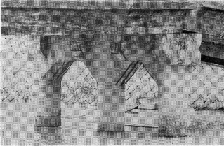
Photo—44 石川橋（戦前），橋脚
