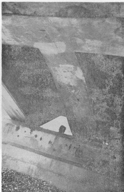
Photo-12 塩屋大橋（大宜味村），“B”
