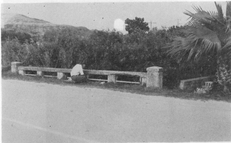
Photo-1 港橋（佐敷村）の高欄
