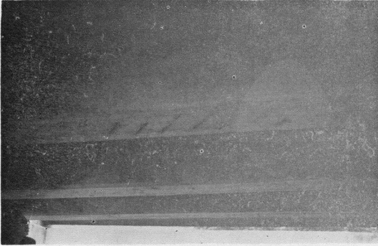
Photo—7 渡海橋(大宜味村)主桁, “D”
