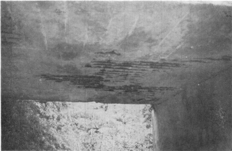
写真-17 橋名不詳（今帰仁村）1923年頃 沖縄最古のRC橋（スラブ橋）
