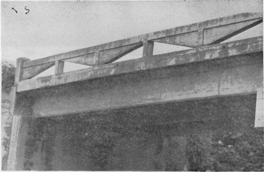
写真-8 平久保橋（石垣島）1957年 “B”
