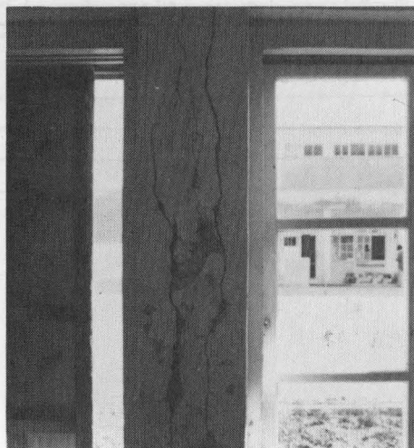
写真-6 東面廊下柱の室内面 国頭中3号棟 (S30)
