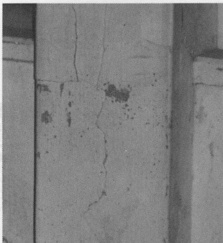
写真—10 2階西面柱の室内面 国頭中4号棟（S31）
