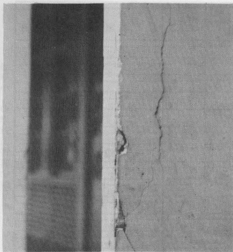
写真-1 南面外廊下柱 有銘小3号棟 (S28)
