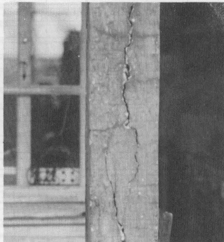
写真-4 外廊下柱 大宜味小中職員室棟
