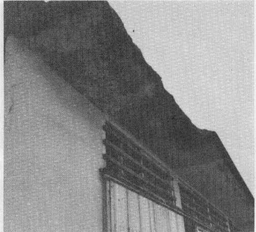
写真-30 国頭中3号棟 (S30) 西面軒 (北端室)
