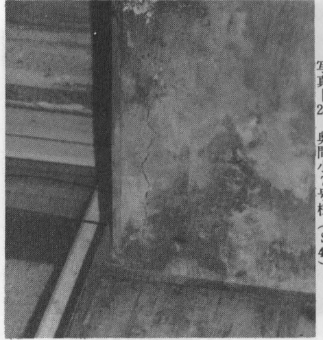
写真-20 北面玄関東側のはり 奥間小7号棟 (S41)
