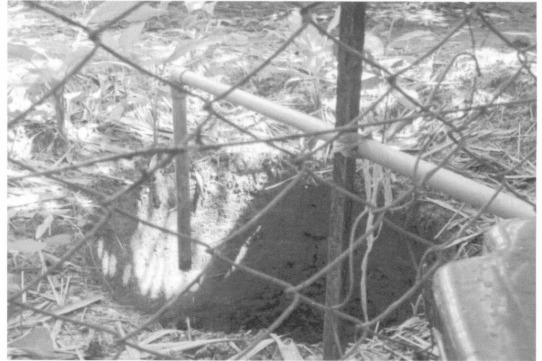
写真Ⅲ-3-16 流し台の排水は敷地に掘った穴へ
