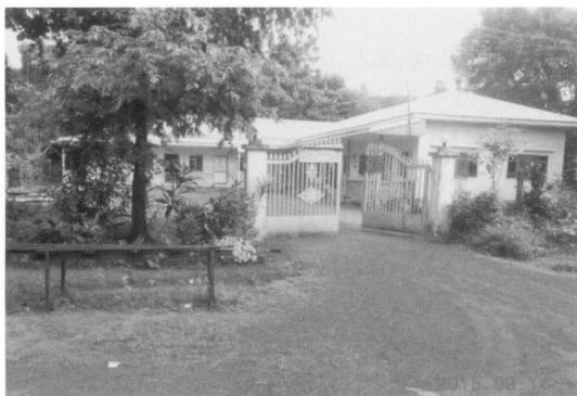
写真Ⅱ-5 『愛の家小学校』全景
