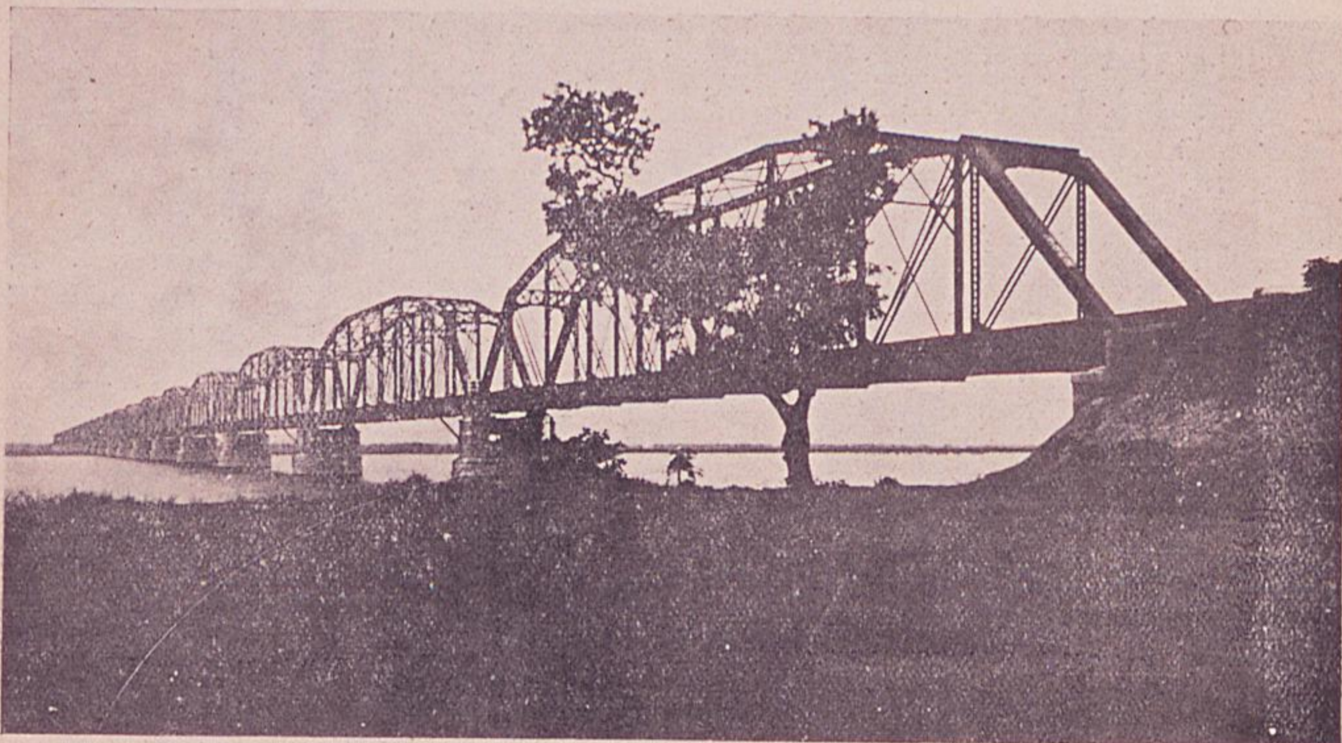
橋 鐵 溪 水 淡 下
