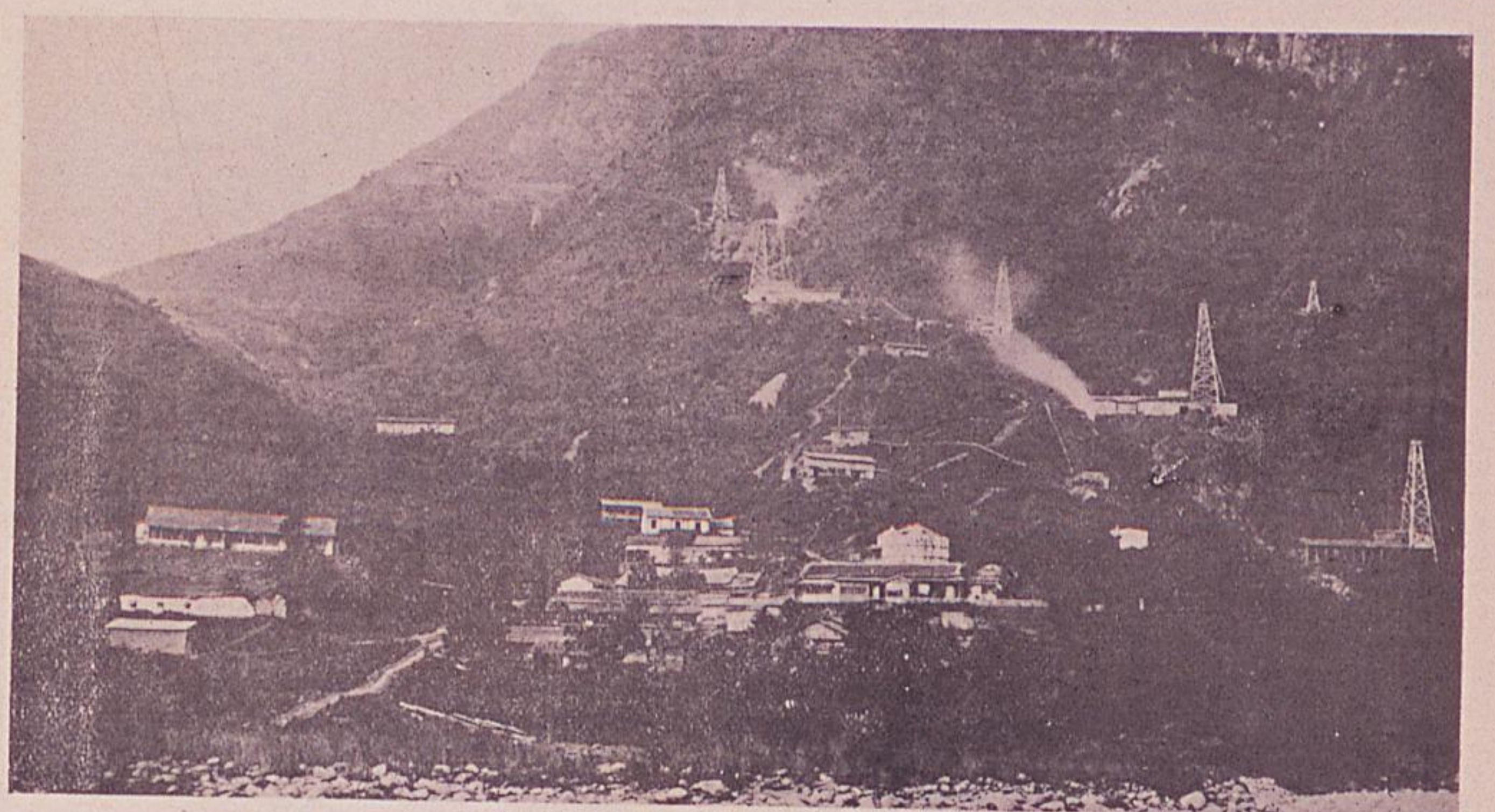
苗栗出礦坑石油礦場
