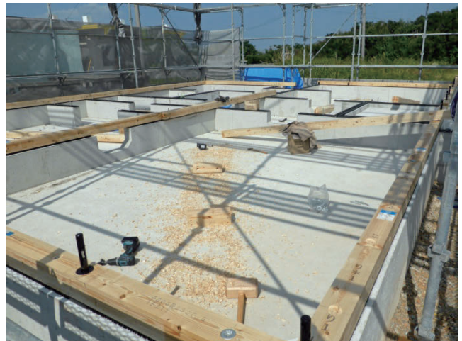
写真-1 沖縄仕様の木造住宅のベタ基礎 (コンクリートを厚めにして土台の高さも少し高めにしている：2019年・本部町にて著者撮影)
