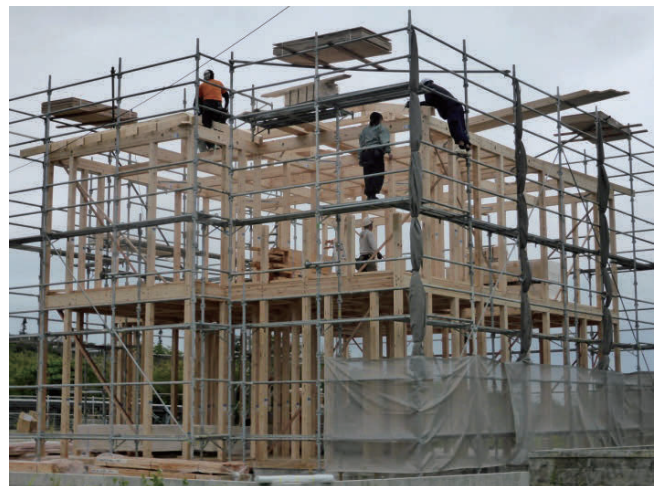
写真-2 沖縄仕様の木造住宅（在来工法）の棟上げ (土台と通し柱は防蟻処理の薬剤を浸透させている：2019年・本部町にて著者撮影)
