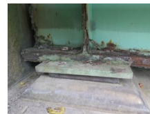
G1桁 赤枠部の近景
