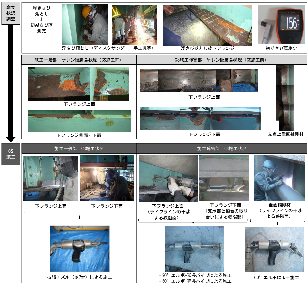
図-13 実証試験施工フロー
