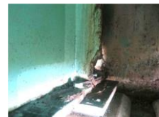
G4桁 支点上垂直補剛材 下フランジ上側・下側
