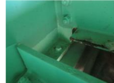
G6桁 下フランジ上側・下側
