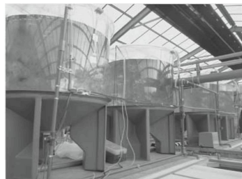
図7. 屋外500L培養槽（4基）
