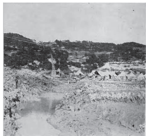
豪雨による雨水を排出するために、広幅の、深い排水溝が掘られた。
