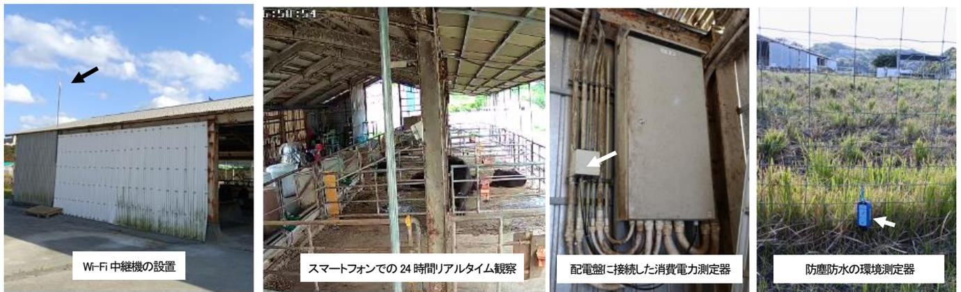
図 3. 牛舎の屋外に設置した Wi-Fi 中継器(左), スマートフォンでの動画観察(中央), 消費電力測定器(中央), 環境測定装置(右)
