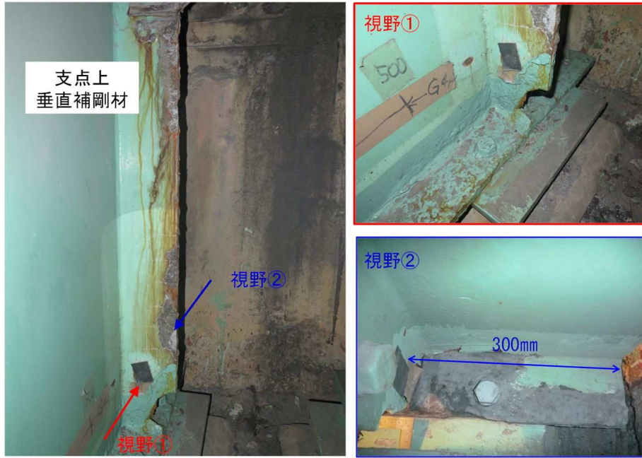
写真 4.3.3 支承部下フランジと支点上垂直補剛材の状況
