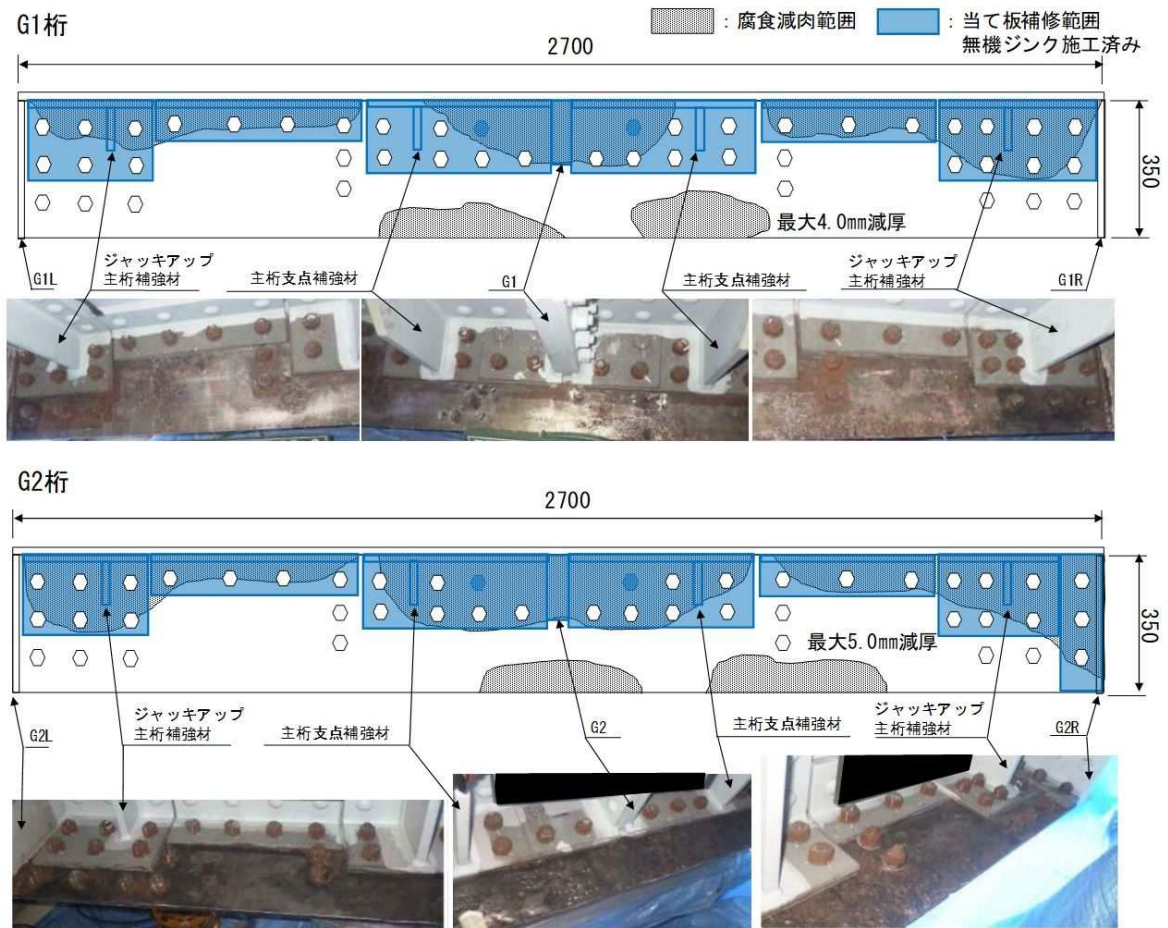
図 4.2.17 試験施工対象桁の腐食状況
