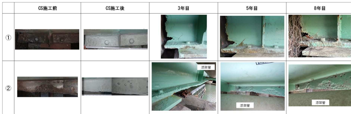
図 4.3.13 添架物干渉部下フランジの外観モニタリング結果
