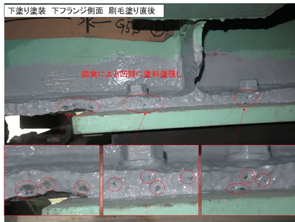
写真 4.3.6 CS 施工後の下塗り塗装時の状況と塗装不良部
