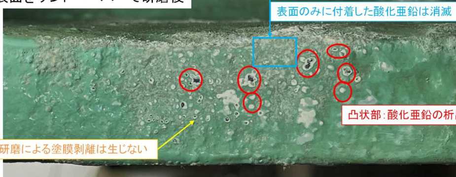
下フランジ側面の表面研磨前後の状況
