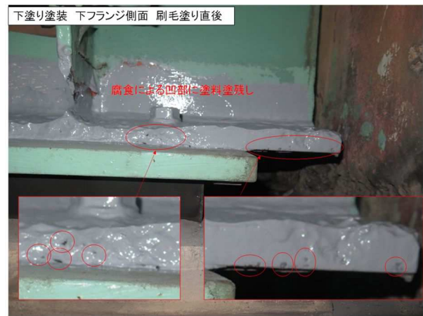
写真 4.3.6 CS 施工後の下塗り塗装時の状況と塗装不良部
