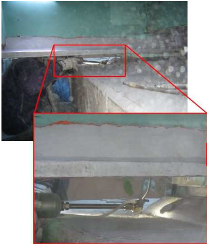
(d) 下フランジ下面 (桁端部)
