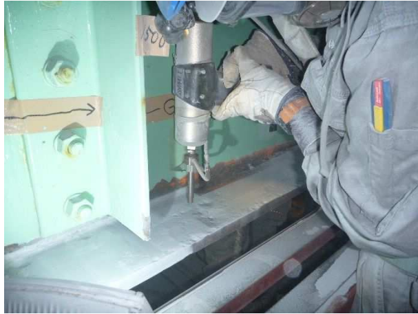
写真 4.3.1 施工一般部下フランジ上面のCS 施工状況
