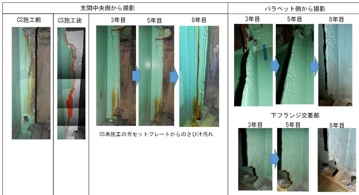
図 4.3.12 支点上垂直補剛材の外観モニタリング結果
