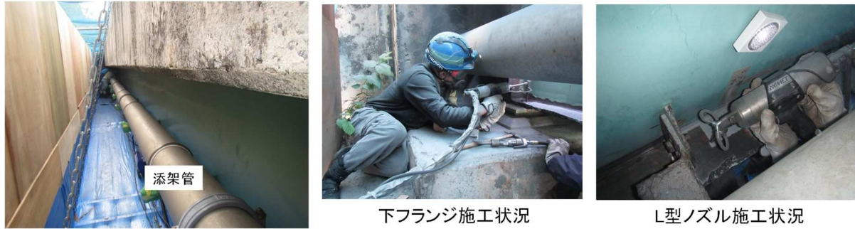
写真 4.3.4 添架物干渉部の CS 施工状況
