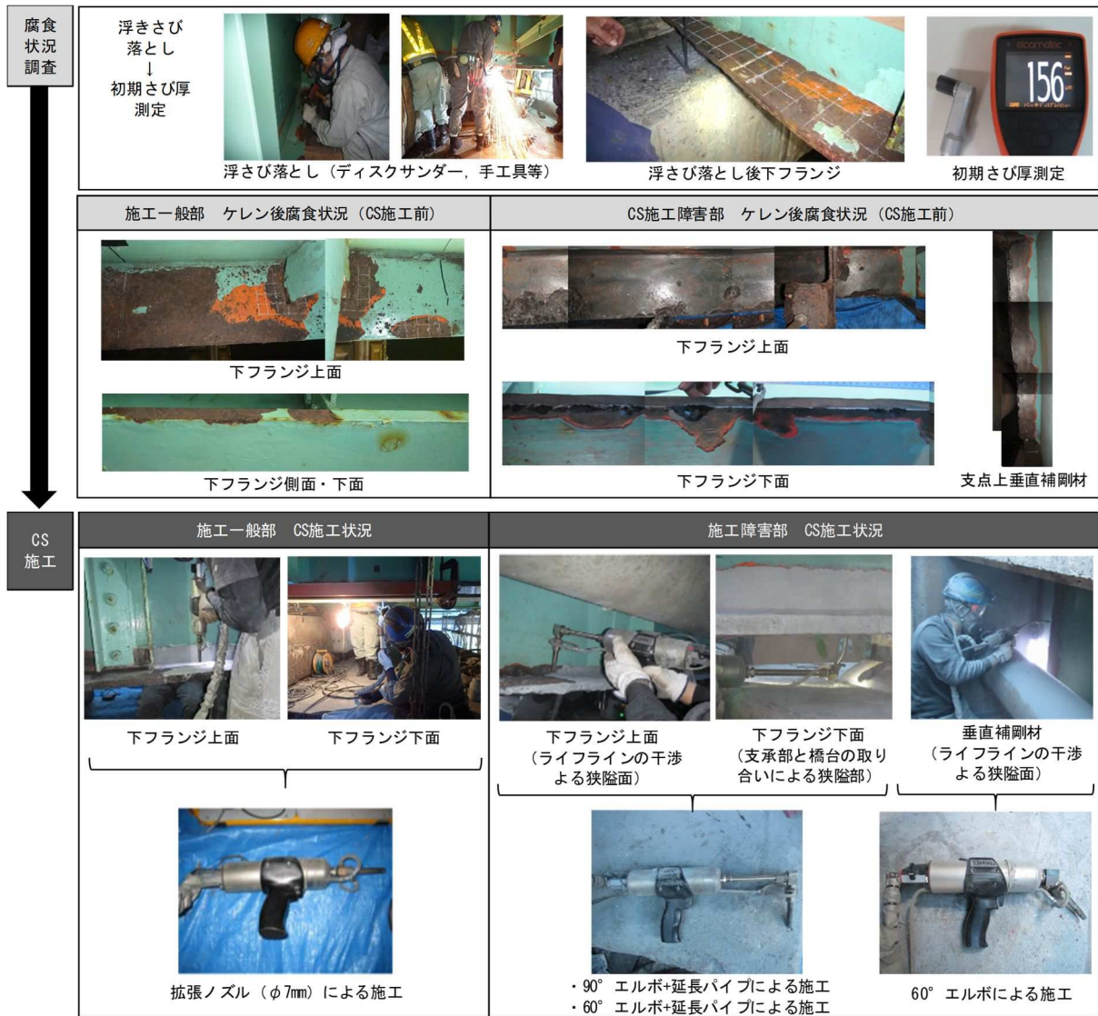
図 4.2.7 実証試験施工フロー
