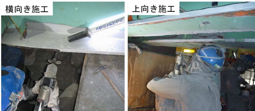
写真 4.3.2 下フランジ板コバ面・下面の CS 施工状況
